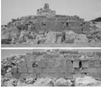
PATARA Deniz Feneri Doğu Cephe
